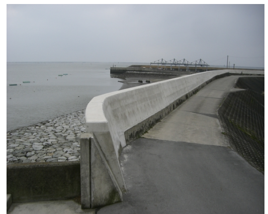
県営海岸保全施設整備事業
