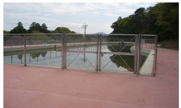
石貫3区1号配水池
