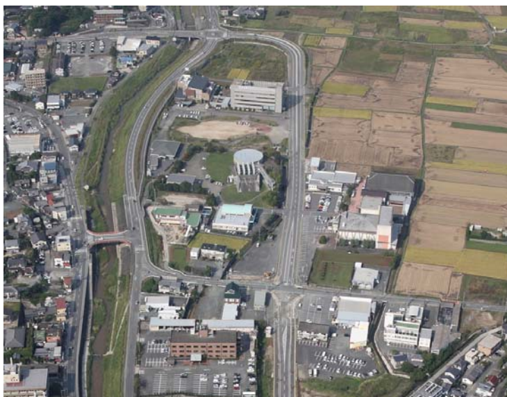
新庁舎建設予定地周辺
