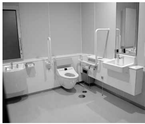
▲玉名市役所本庁舎に設置してある多目的トイレ「誰でもトイレ」
