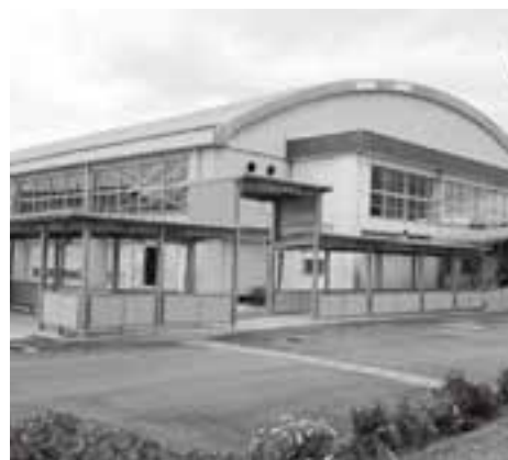
▲外壁と屋根を修理する玉名中学校屋内運動場
