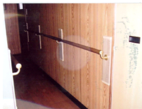
廊下手すりの設置
