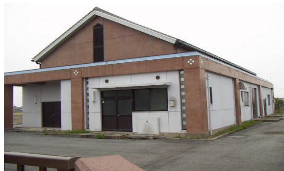
九番農業集落排水処理場
