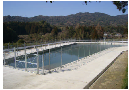
石貫4区2号配水池
