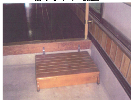
玄関踏み台設置による段差解消
