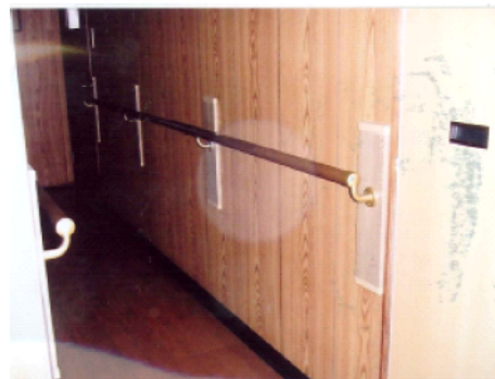
廊下手すりの設置
