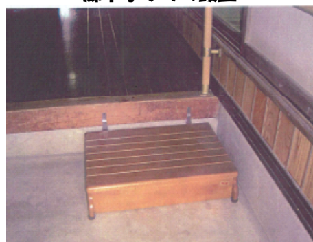
玄関踏み台設置による段差解消
