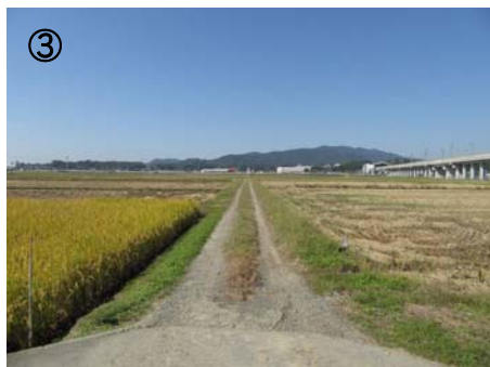
河崎迫間2号線(終点西方向)
