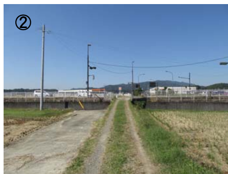
河崎迫間2号線(起点西方向)
