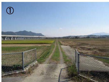
河崎迫間2号線(起点東方向)
