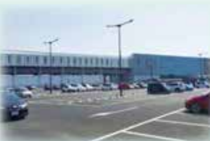
増設された西側駐車場
