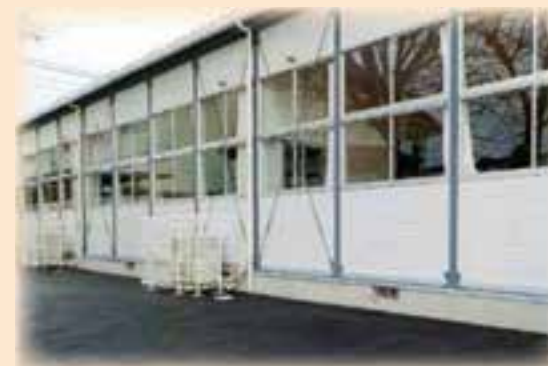
築山小学校プレハブ校舎
