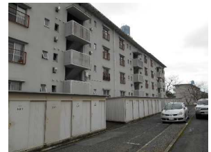
給排水管等の改修
