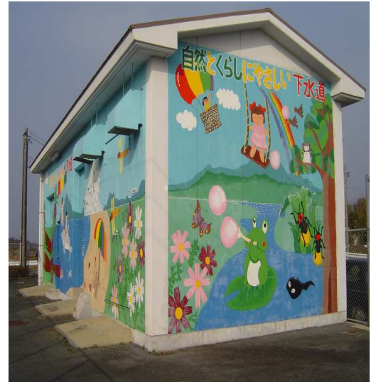
大野下汚水中継ポンプ場
