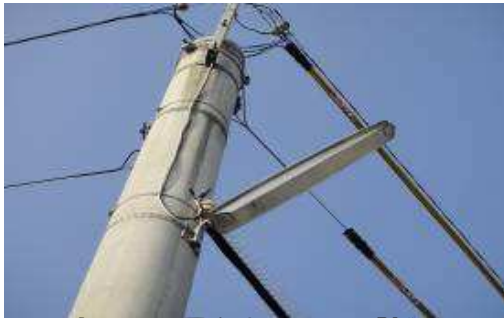
省エネ・長寿命のLED防犯灯
