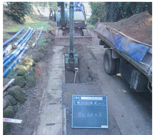
天水町東地区配水管布設工事
