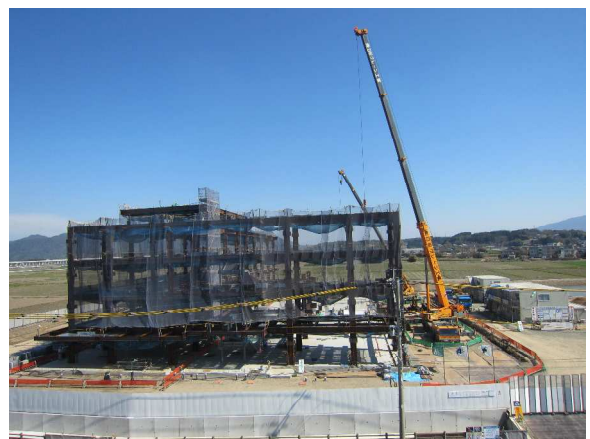
建築工事中の新庁舎（H26. 3. 17現在）
