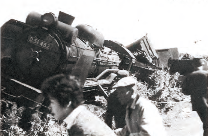
列車事故現場
