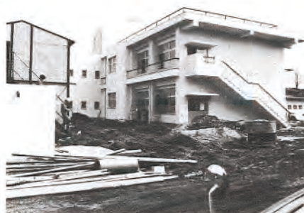
建設中の睦合小学校
