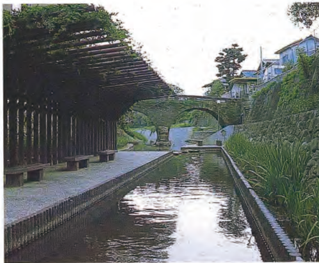
■水際緑化都市モデル地区、整備された裏川周辺
