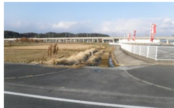
道路・下水道整備予定地
