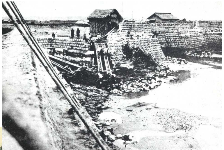
六枚戸復旧工事の様子 （『昭和2年熊本県潮害誌』より）
