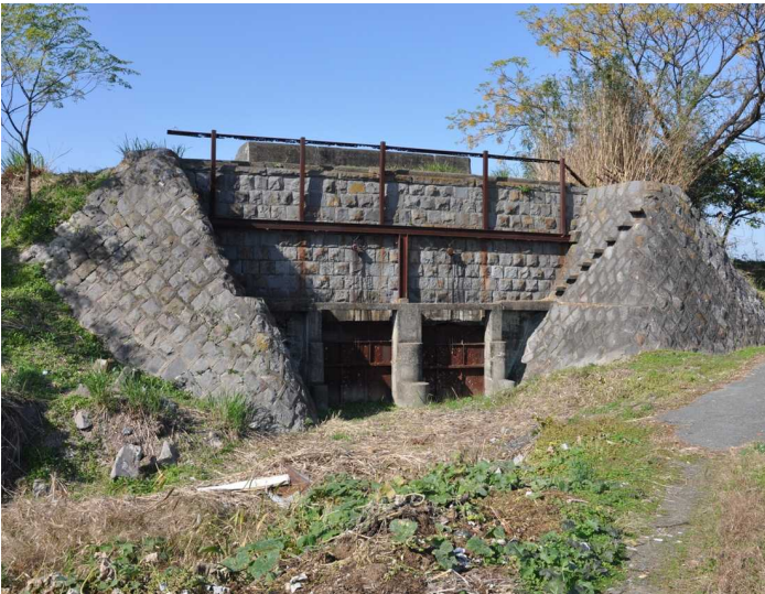
左上/末広開樋門（六枚戸） （手前：西三枚戸樋門、奥：東三枚戸樋門） 左中/明丑開樋門（干拓地側から） 左下/明豊開樋門（干拓地側から） 右上/末広開東三枚戸樋門水門部 右下/末広開二枚戸樋門（海側から）
