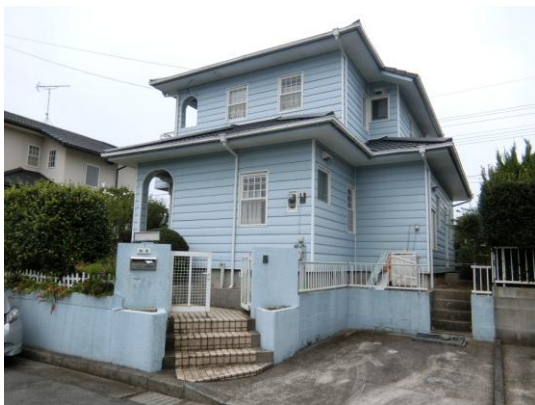
【遠景】平成 29 年 9 月 撮影
