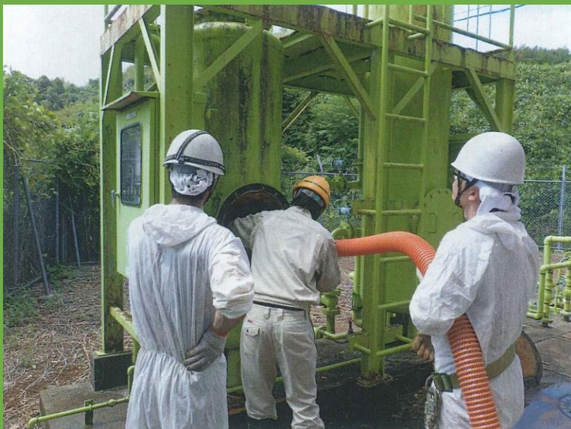
旧玉名市クリーンセンター急速濾過装置の濾材入換え作業
