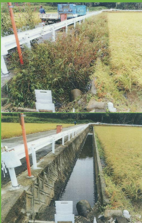
浚渫前（上）、浚渫後（下）
