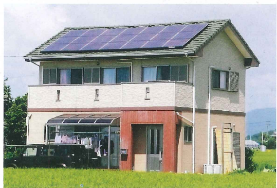
【太陽光発電システム】
