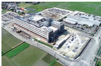
● 作業状況 (2020年7月)
