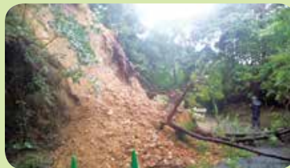
土砂が崩れた林道小岱山線
