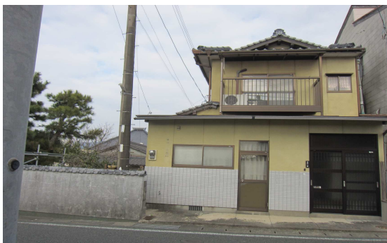
【外観】 令和2年11月 撮影
