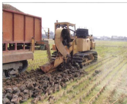
暗渠排水事業・暗渠管埋設状況
