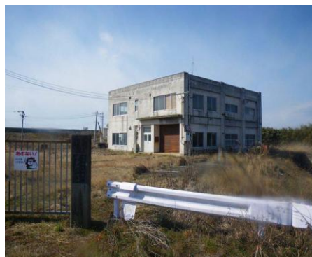
県営湛水防除事業負担金 横島排水機場外観
