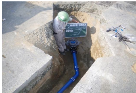
天水町東地区配水管布設替工事
