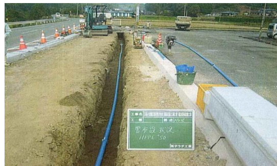
雲雀丘地区配水管布設替工事
