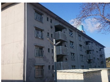
給排水管等の改修
