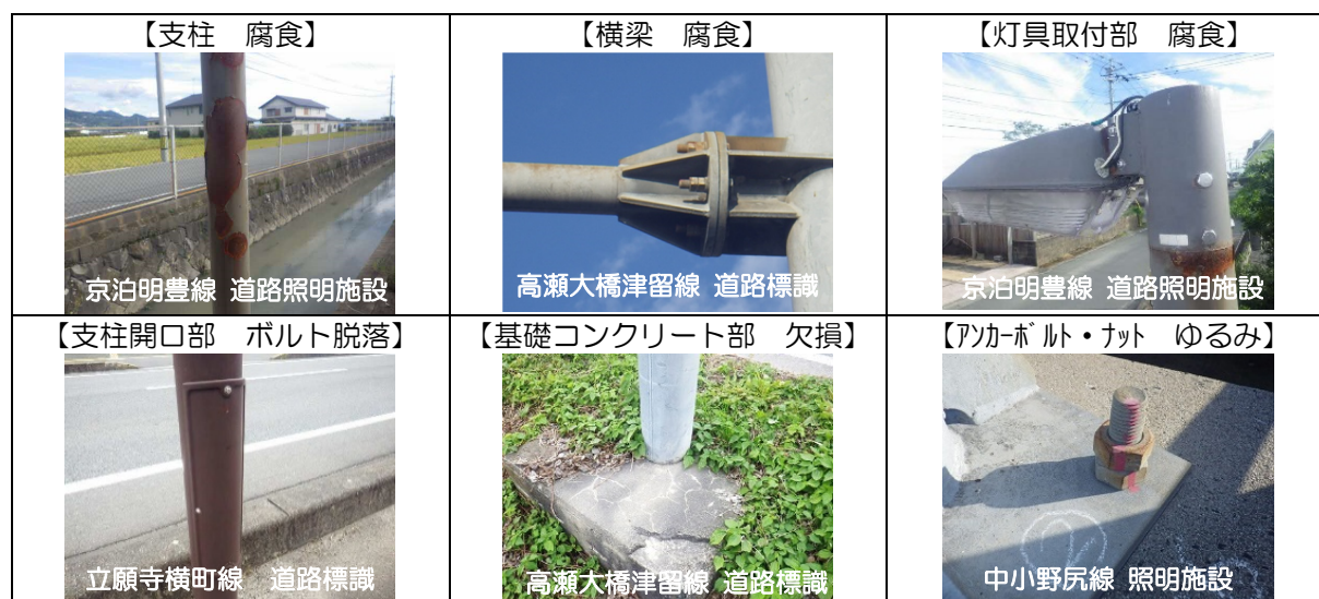
図 2-6. 損傷状況例
