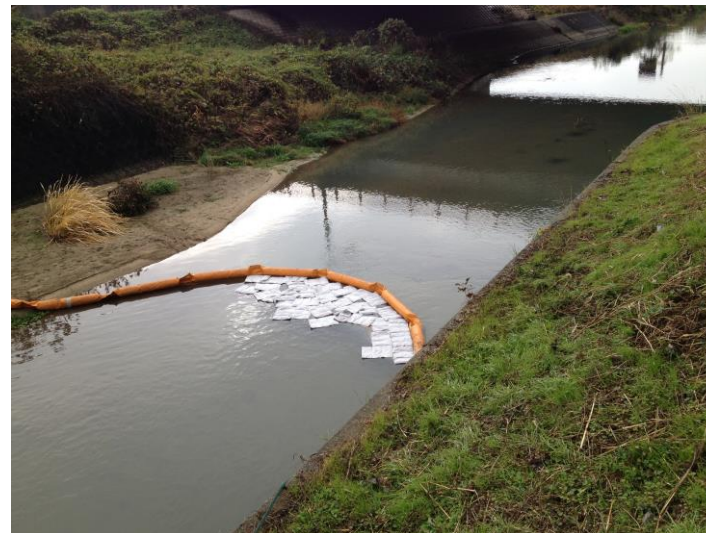
繁根木川に流出したA重油を吸着マットで回収している様子
