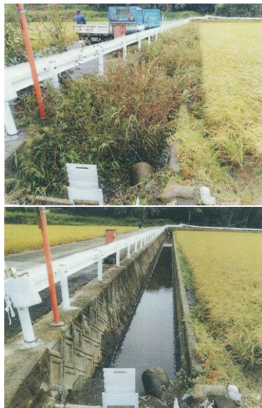
浚渫前（上）、浚渫後（下）
