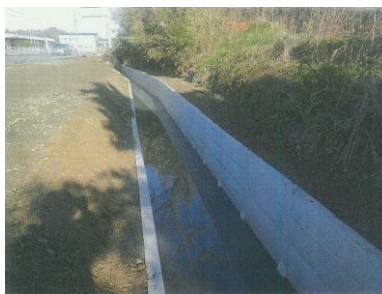
工事前（上）、工事後（下）
