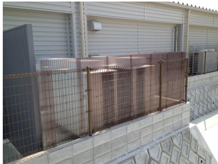
冷凍機用圧縮機の騒音に対する防音壁の設置
