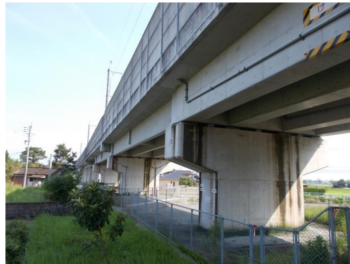
新幹線高架橋がつくり出す日陰
