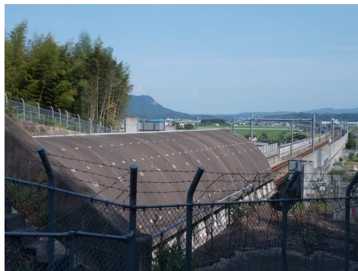
新幹線大坊トンネル出入口（大坊側）
