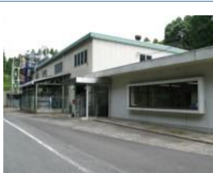
平成30年度まで稼働していた第2衛生センター（和水町）
