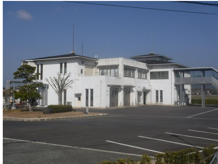
令和元年度にリニューアルした第1衛生センター（旧岱明町）
