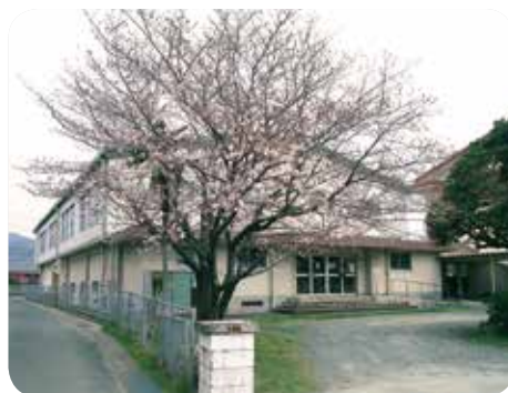
▲築山小学校体育館
