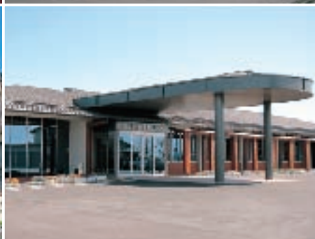
横島総合支所
