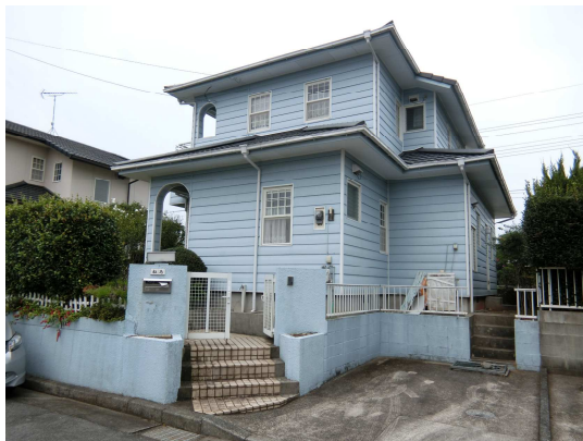
【遠景】平成 29 年 9 月 撮影
