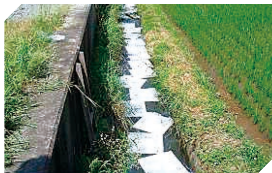
▲吸着マットによる流出油の回収作業
