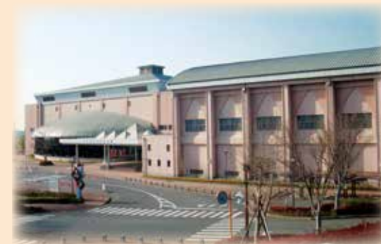
▲改修を行なう玉名市総合体育館
