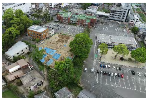
旧本庁舎跡地の状況
