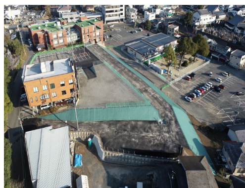
旧本庁舎跡地の状況
