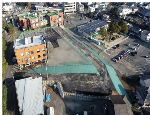
旧本庁舎跡地の状況
