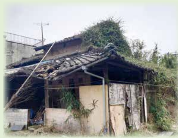
▲市内の空き家
